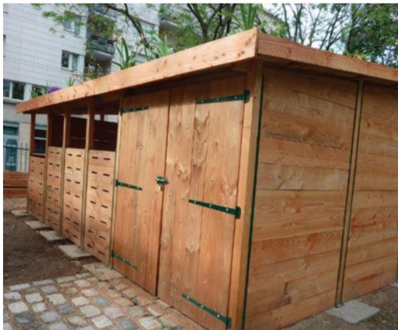
Figure B.2. Pavillon de compostage du composteur de quartier au square Héloïse et Abélard. Source : blog Compost à Paris
