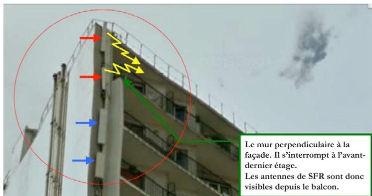
**En haut de l'immeuble**, 2 antennes SFR vers azimut 120°, en dessous 2 antennes BOUYGUES TELECOM vers azimut 120°.
